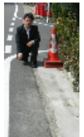
大枝西長町、側溝工事
