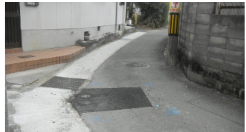
下津林楠町の側溝の暗渠化
